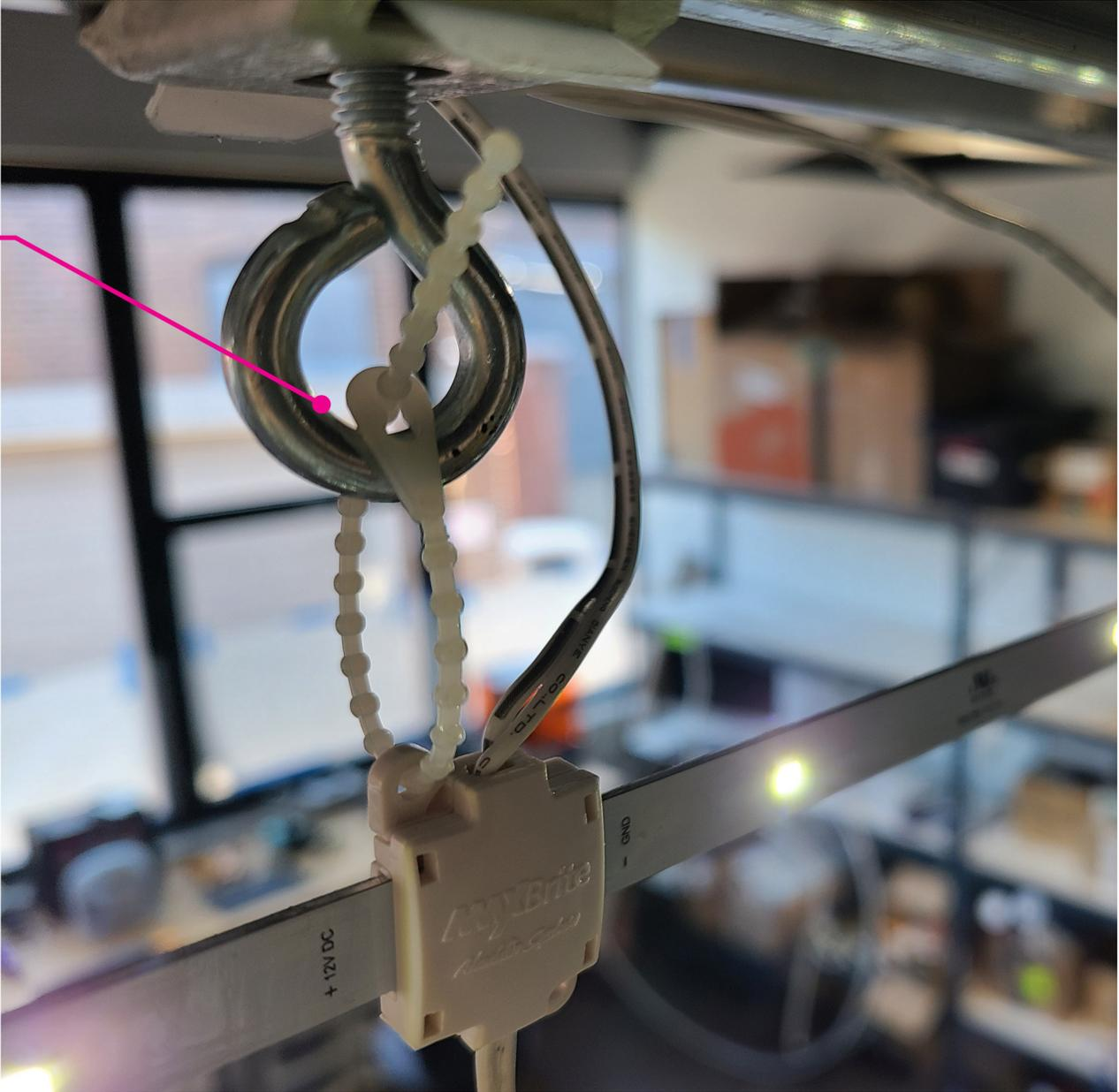
**SECURE EACH STRAND OF LED TO THE EYE HOOKS. THE PLASTIC CONNECTORS CAN BE ADJUSTED AS NEEDED TO LEVEL THE STRIPS.**
